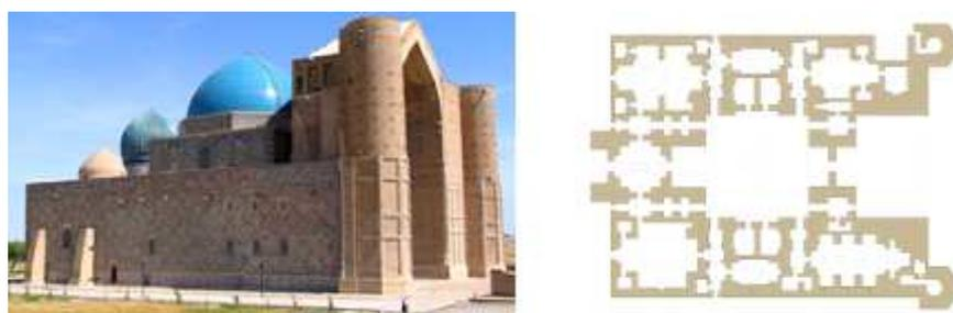
Рис. 2. Сооружение мавзолея Ахмеда Ясави: а-общий вид, б-план мавзолея с разделением на восемь независимых объемных блоков осадочными швами
