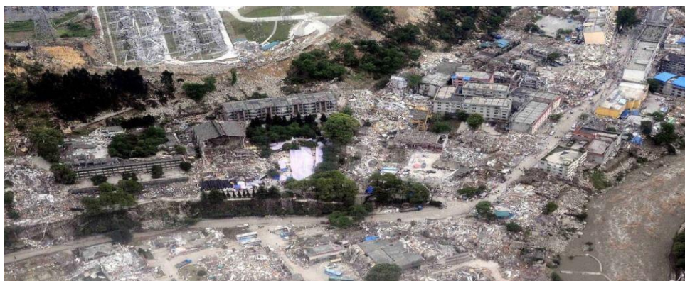
Рис.1.Разрушения, вызванные землетрясением
