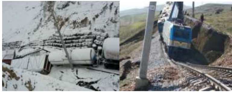
Рис. 3. Последствия селевых потоков на железнодорожный транспорт.
